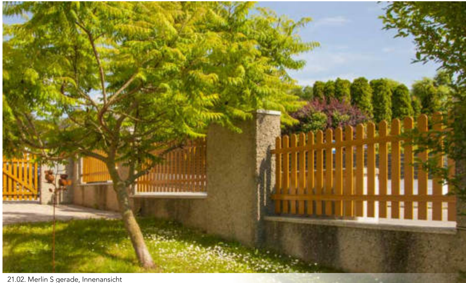
21.02. Merlin S gerade, Innenansicht
